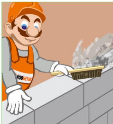
Щетка-сметка предназначена для очистки поверхности от пыли. Применяется после штробления блока, перед грунтовкой и окраской поверхности стен
