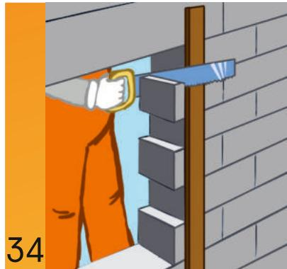
Для точного выреза оконного проема необходимо использовать направляющую рейку, выставленную и закре-пленную по краю проема
