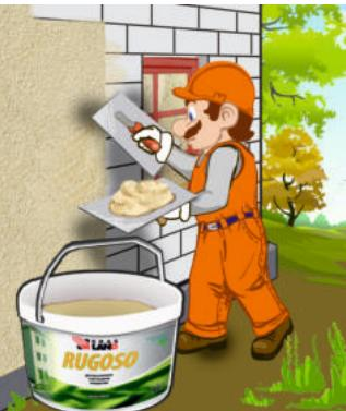
После высыхания грунтовки нанести на стену заранее заколерованное текстурное покрытие RUGOSO используя хоппер-пистолет, шпатель или кельму. После нанесения сформировать необходимый рельеф
