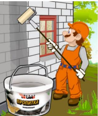
Обработать поверхность укрепляющей пропиткой для внутренних и наружных работ Krasland G02 с увеличенным содержанием дисперсии, и дать просохнуть
