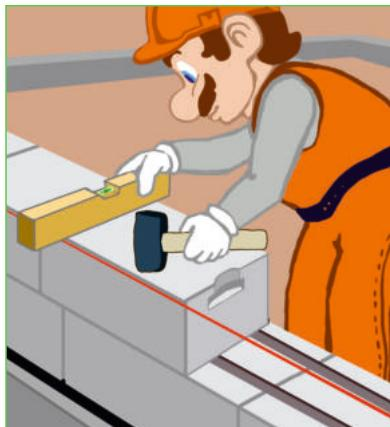
Киянка резиновая с деревянной ручкой применяется для точного позиционирования вновь уложенных блоков в кладке. Резиновая головка позволяет при работе избежать деформации газобетонных блоков.
