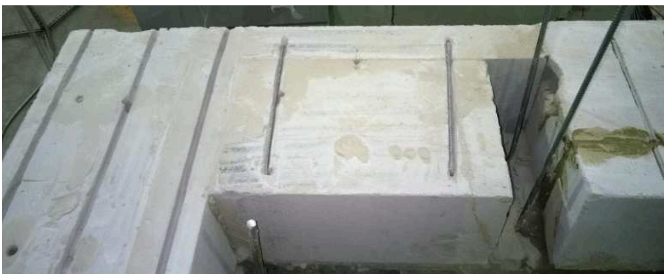
Фото 2. Армирование кладки из газобетонных блоков
