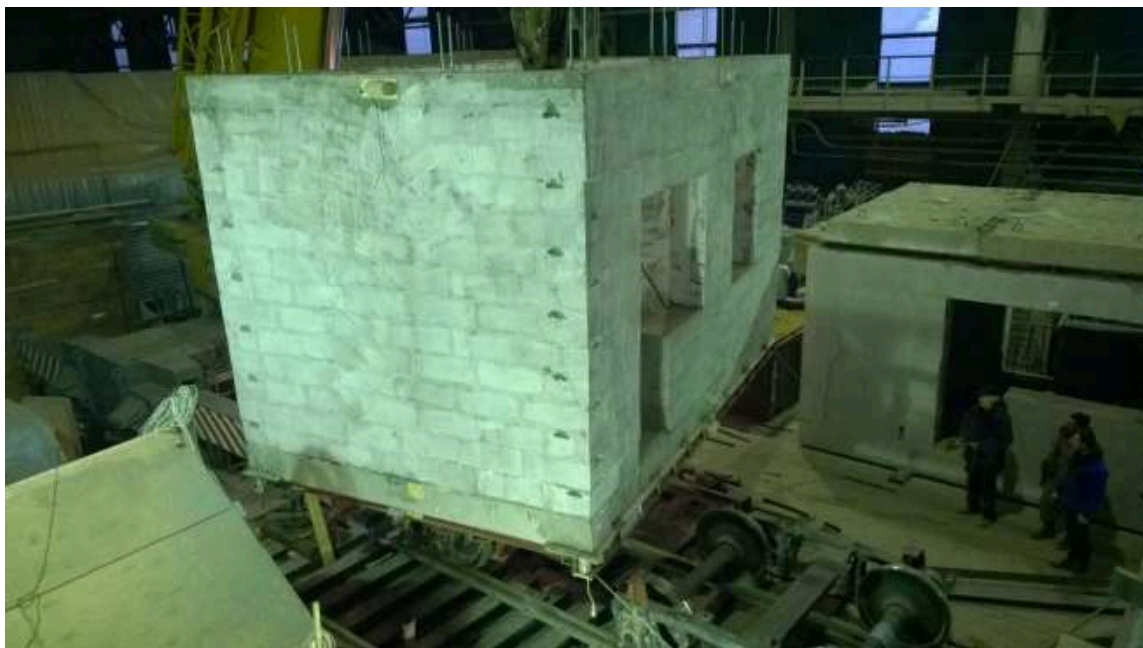
Фото 13. Разворот фрагмента здания на 90°
