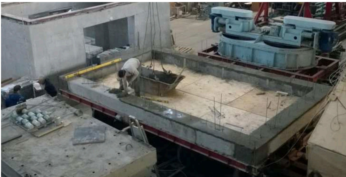
Фото 1. Покрытие нижнего железобетонного пояса выравнивающей стяжкой.
