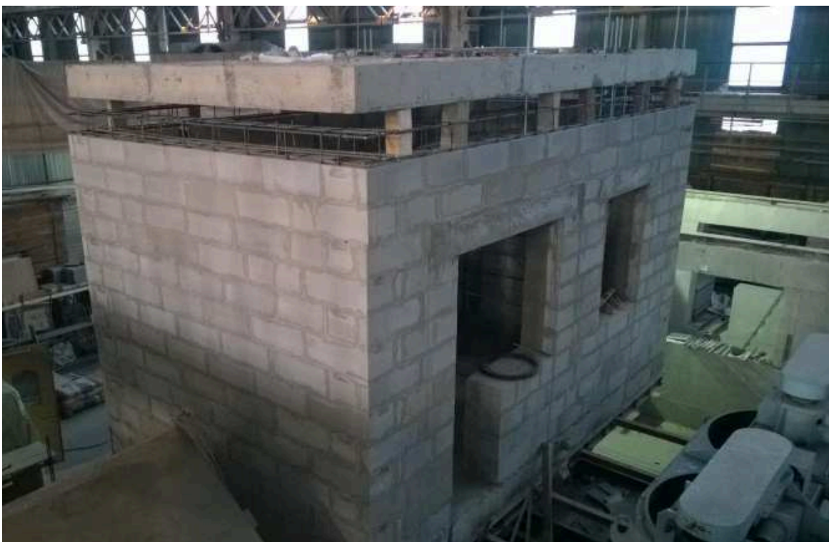
Фото 6. Установка закладных деталей для крепления плит.
