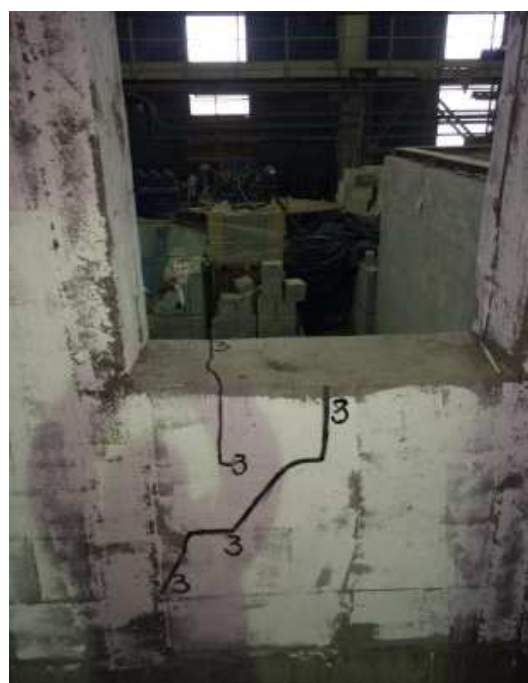
Фото 14, 15. Образование трещин в кладке стены расположенной по оси «А» с внутренней стороны
