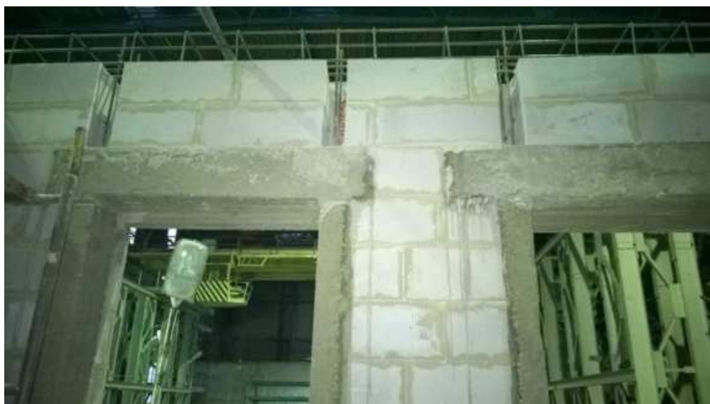
Фото 5. Изготовление железобетонных включений.
