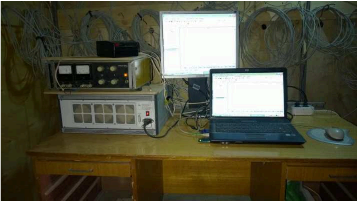
Фото 10. Комплекс оборудования для регистрации колебаний фрагмента при проведении испытаний на сейсмоплатформе.
