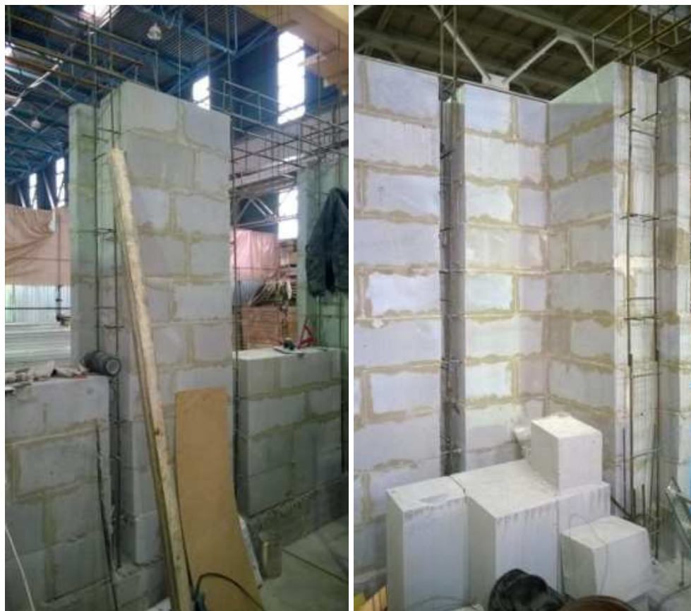
Фото 3, 4. Армирование железобетонных включений.
