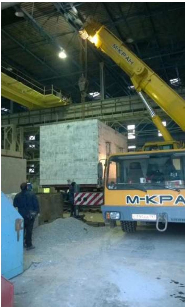
Фото 11. Подъем фрагмента с помощью автокрана
