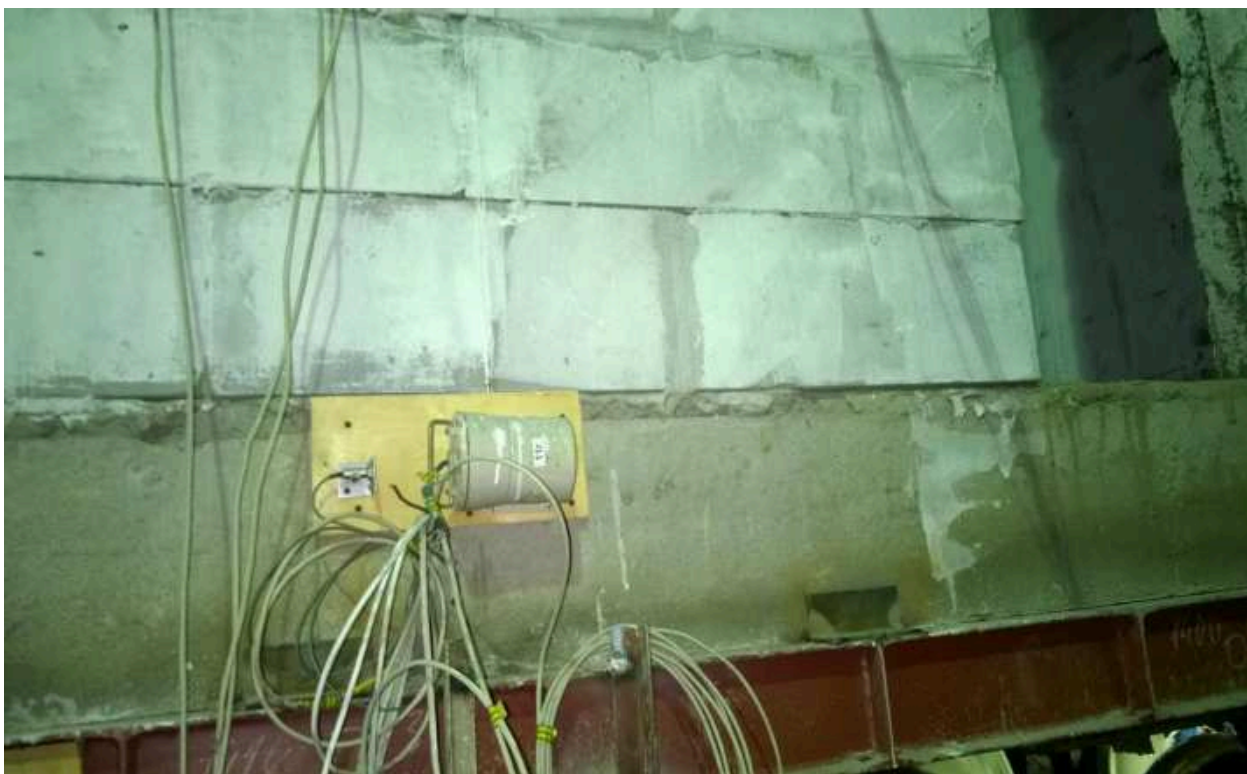
Фото 9. Установка датчиков ОСП-3М и ВС 202 на вертикальной поверхности железобетонного пояса фрагмента
